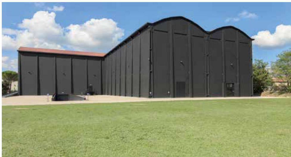
16. Gli Ex Seccatoi del Tabacco al termine dei lavori, veduta esterna.
